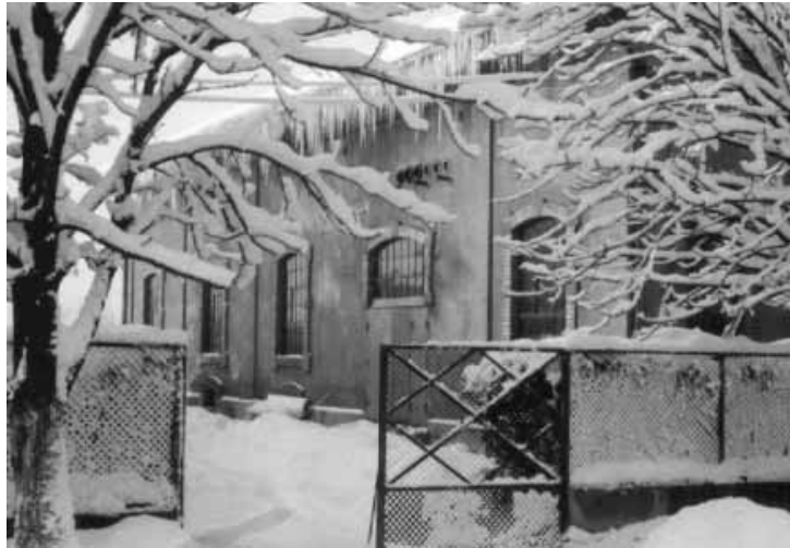
Das Maschinengebäude im Januar 1964
